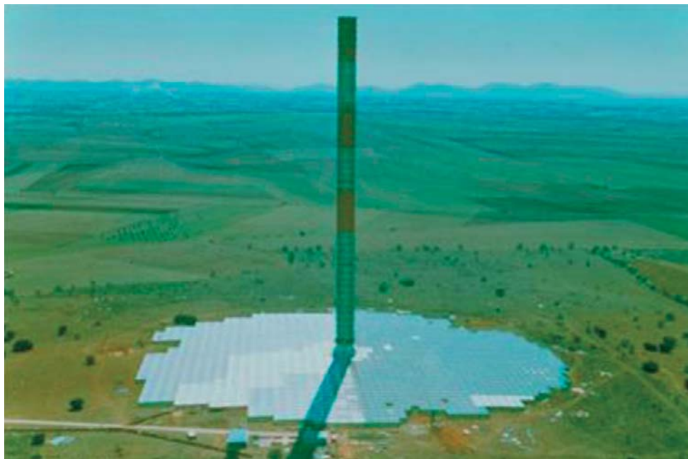
Εικόνα 6: Πρωτότυπη πιλοτική ηλιακή καμινάδα στις Manzanares της Ισπανίας [4]
