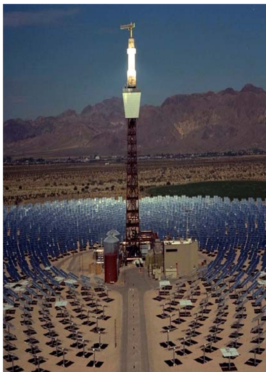
Εικόνα 7: Η τεχνολογία του ηλιακού πύργου (Πηγή Sandia)
