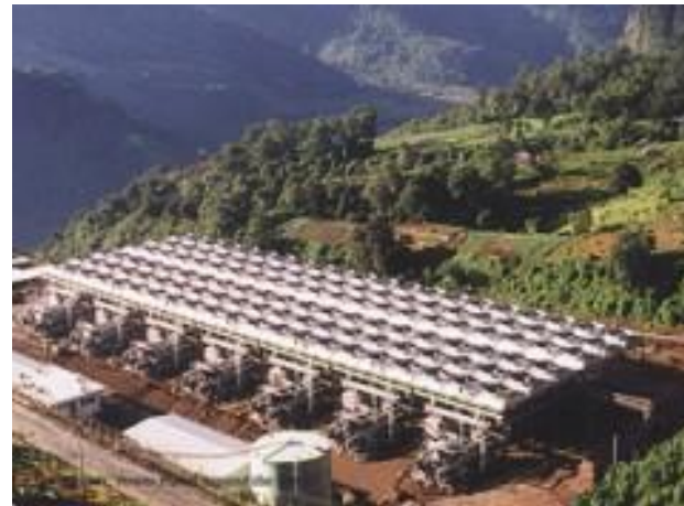
Μονάδα ηλεκτροπαραγωγής δυναμικού κύκλου στη Γουατεμάλα
