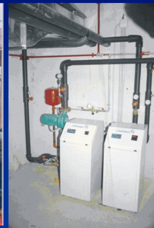
Δημαρχείο Πυλαίας Θεσ/νίκης: Ανόρυξη γεωτρήσεων - αντλίες θερμότητας & σύστημα σωληνώσεων: Επιφάνεια 2500 m 2 - 21 τυφλές σωλήνες σε βάθος 80 m
