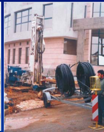
Δημαρχείο Πυλαίας Θεσ/νίκης: Ανόρυξη γεωτρήσεων - αντλίες θερμότητας & σύστημα σωληνώσεων: Επιφάνεια 2500 m 2 - 21 τυφλές σωλήνες σε βάθος 80 m
