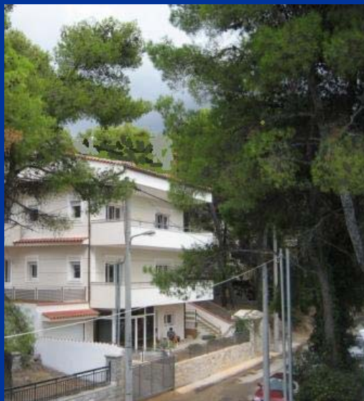
Νέα Πεντέλη: Τριώροφη κατοικία 400 m 2 , με κατακόρυφο κλειστό κύκλωμα (σε γεωτρήση), μέχρι βάθος 100 m (ισχύς 34 kW)
