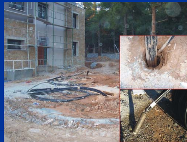
Ελαιώνες Πανοράματος Θεσ/νίκης: Είσοδος σωλήνων γεωεναλλάκτη στο εσωτερικό της γεώτρησης (κατακόρυφο κλειστό κύκλωμα) και η κεφαλή του γεωθερμικού βρόχου που εισάγεται
